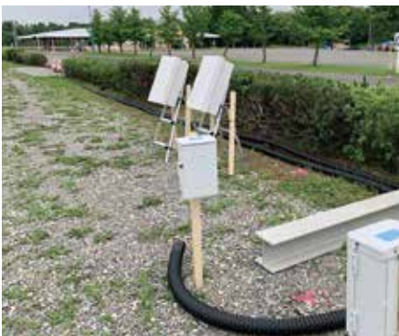
北愛国交流広場電気設置工事（令和5年6月）
