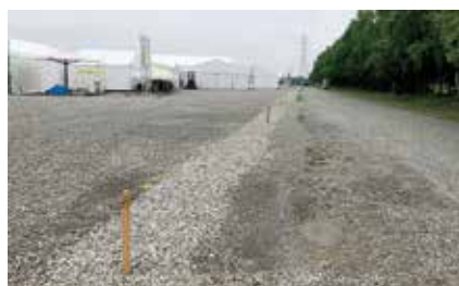
会場西側縁に施工された暗渠上の注意ロープ
