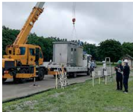
キュービクルの設置
