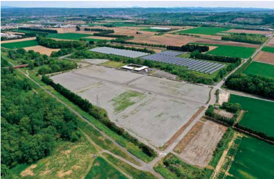
大幅な改修工事を行った北愛国交流広場（令和5年5月24日撮影）
