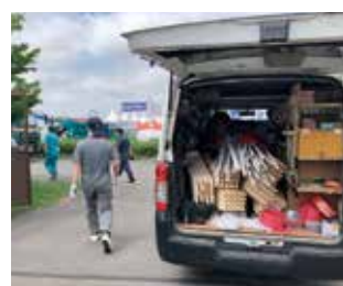
看板等の設置作業
